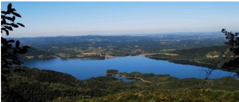
Figura 2.2.7.3 – Barragem do rio São Bento no município de Siderópolis
